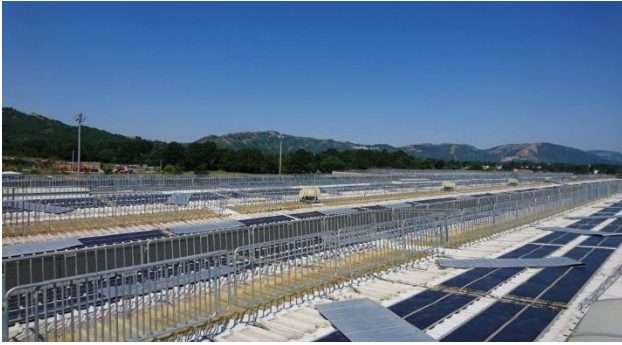
Stato prima dell'intervento
