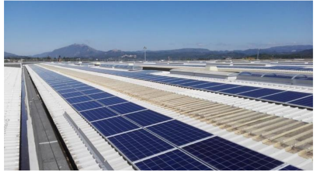
Stato dopo la sostituzione
